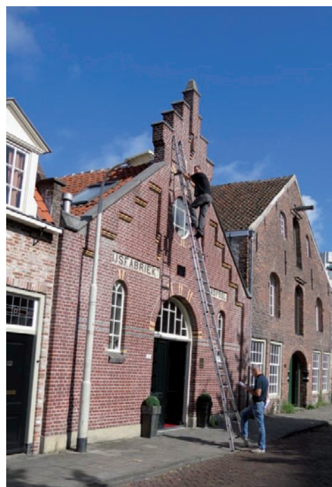
Inspectie door de Monumentenwacht
