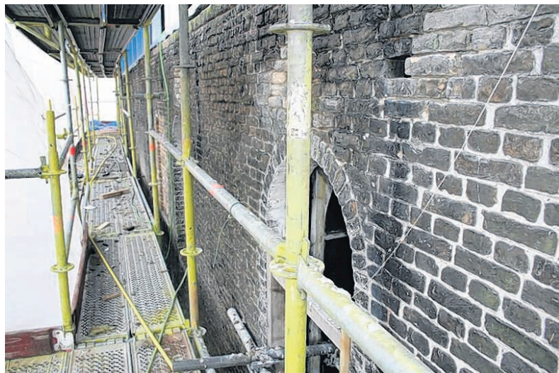
Restauratiesteigers tegen de eeuwenoude muren van 't Klapcot. Het pand werd in de 17e eeuw als brouwerij - De Witte Leeuw - opgetrokken.
