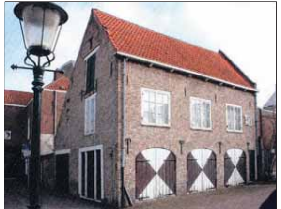
Het pand aan het Stadserf dat opgeknapt gaat worden.
