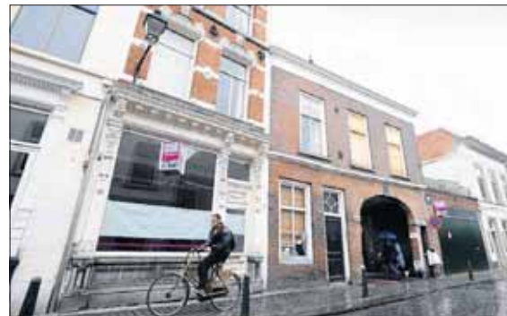
Vier gebouwen in de Annastraat en het aanpalende Stadserf worden opgeknapt.
