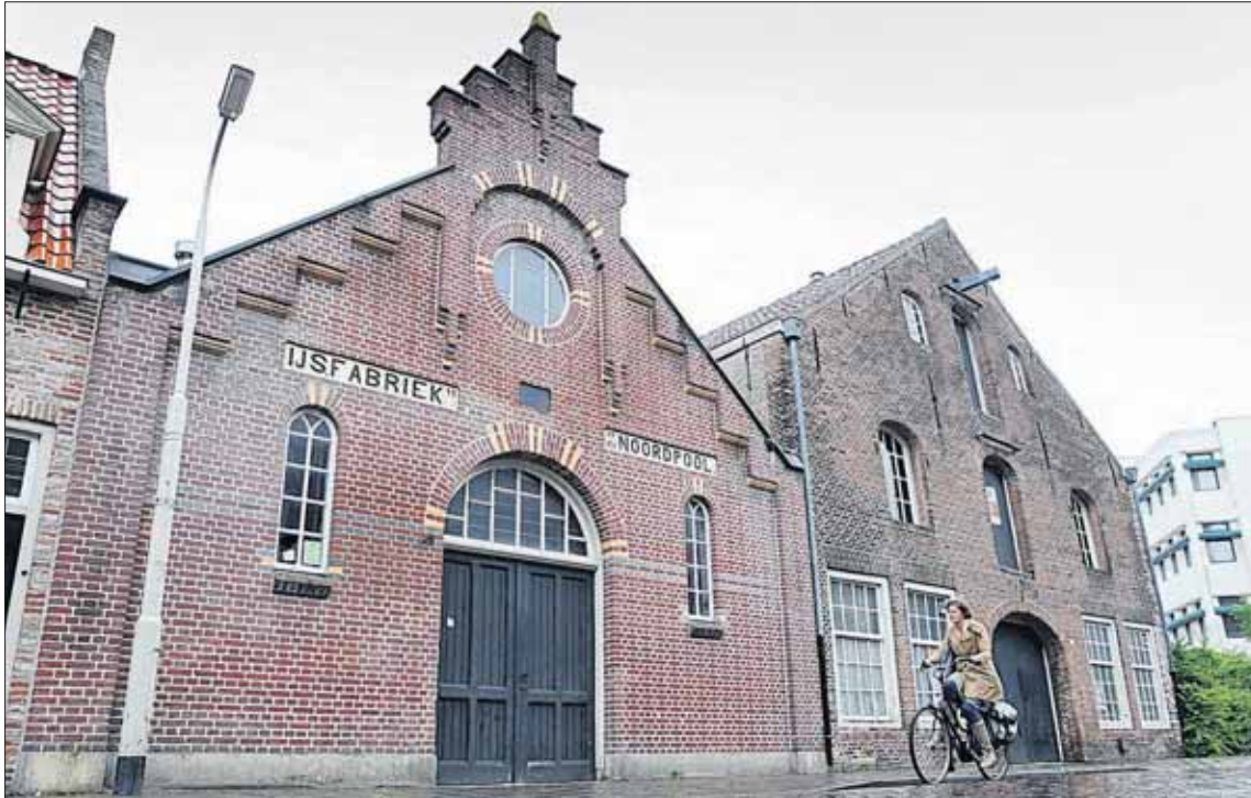
De panden van de voormalige ijsfabriek De Noordpool en de voormalige pelmolen aan de Jan van Polanenkaade worden ook gerestaureerd.
