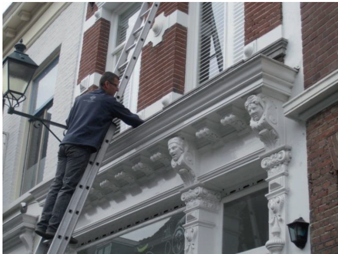
Monumentenwacht inspecteert St. Annastraat 17
