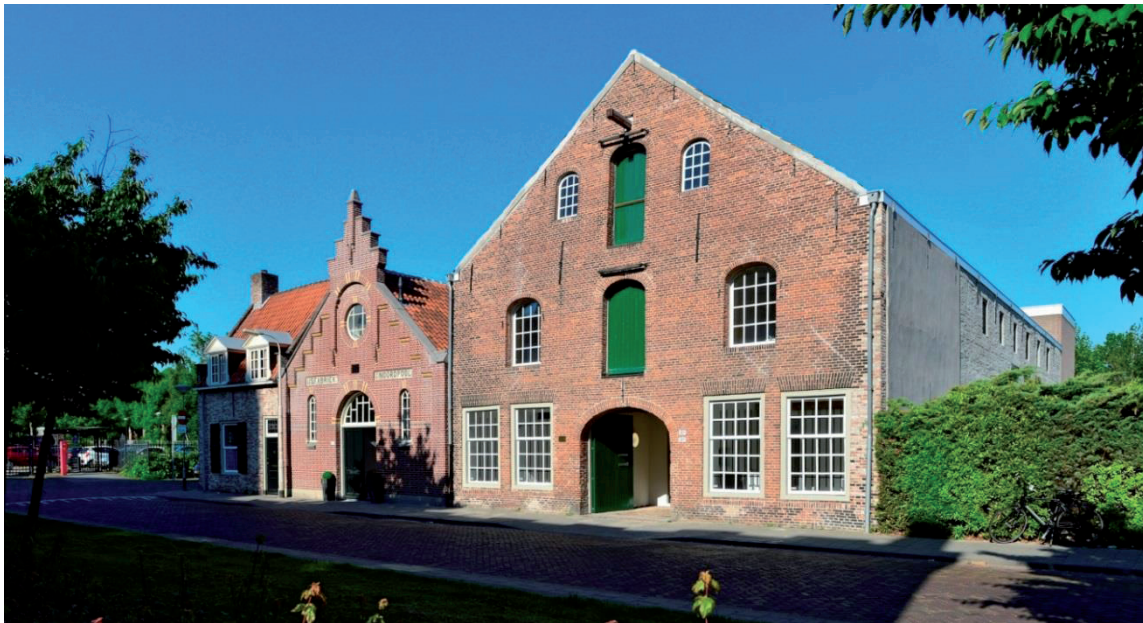
De Noordpool & De Pelmolen – foto Rienks Architecten
