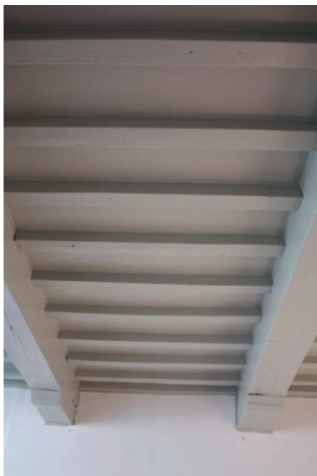
Kinder- en moerbalken in Kerkplein 3
