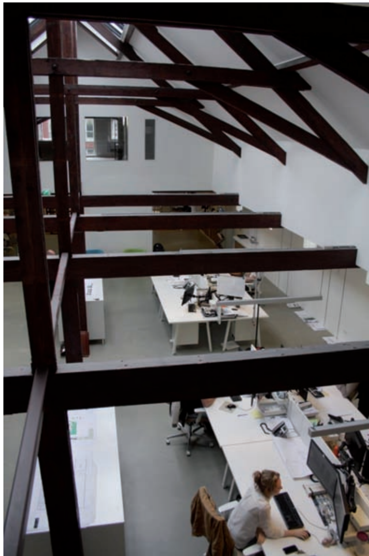
De balken en de kapconstructie in De Pelmolen
